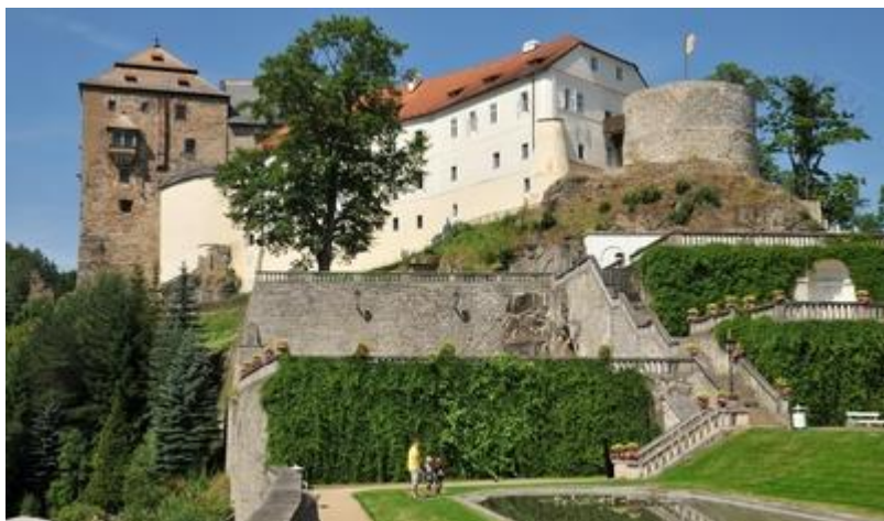
Hrad a zámek Bečov nad Teplou (foto web CoKdyKam)
