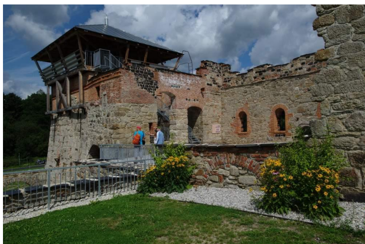
Dřevouhelná vysoká pec v Šindelové
