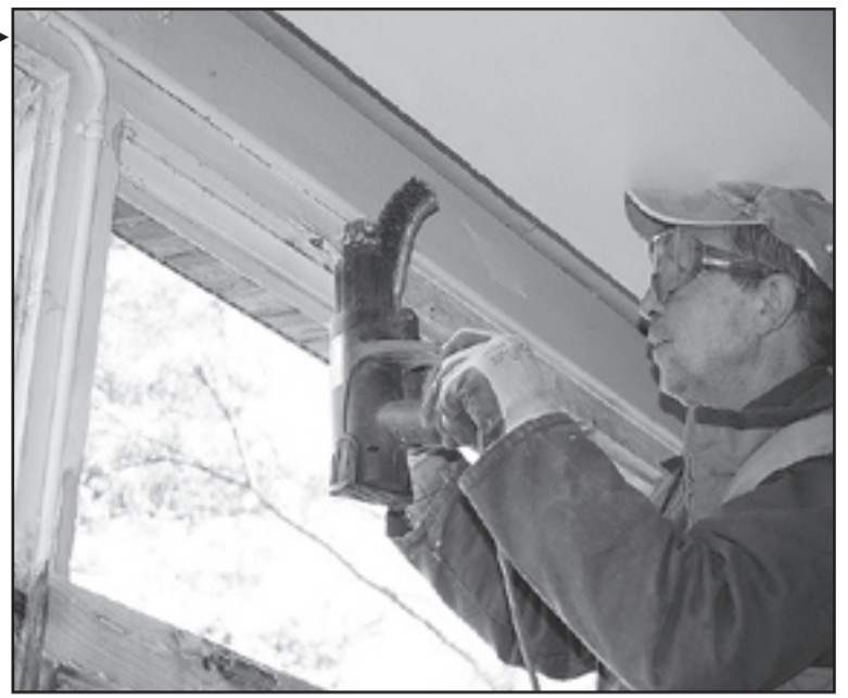
Příznivého počasí se na „Kobzáňce“ využívá i k repasi původních oken.
