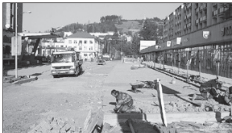
Jednou z akcí financovaných z IPRM je také právě probíhající rekonstrukce náměstí Svobody.
